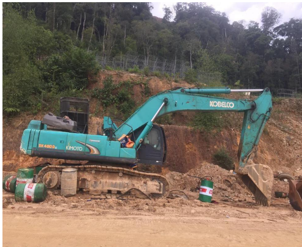
Máy đào bánh xích Kobecol 480-8, công suất 2200 – 2500 m 3 /ca
