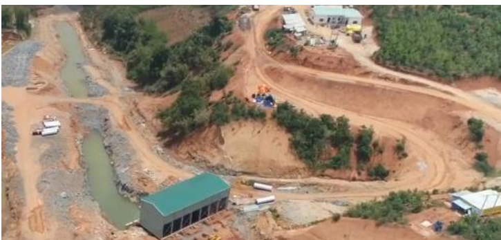
Hình ảnh tổng quan công trình thủy điện Đăk Piu 2
